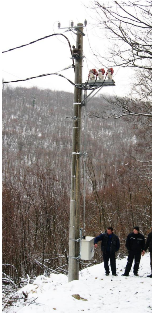
Sl.1. Instalirana vakuumska rastavna sklopka sa elektromotornim aktuatorom IP200
